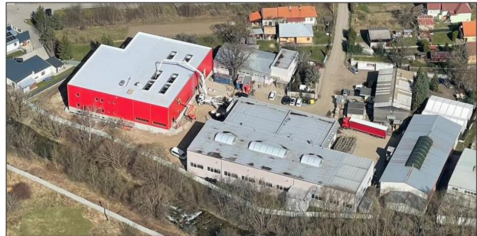
Ab 07.2024 neue Produktions- und Lagerhalle
